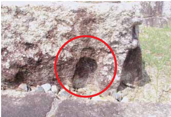
写真2 南西面の大きな矢穴
