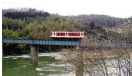
【写真1】三河線で唯一矢作川に架かる鉄橋
