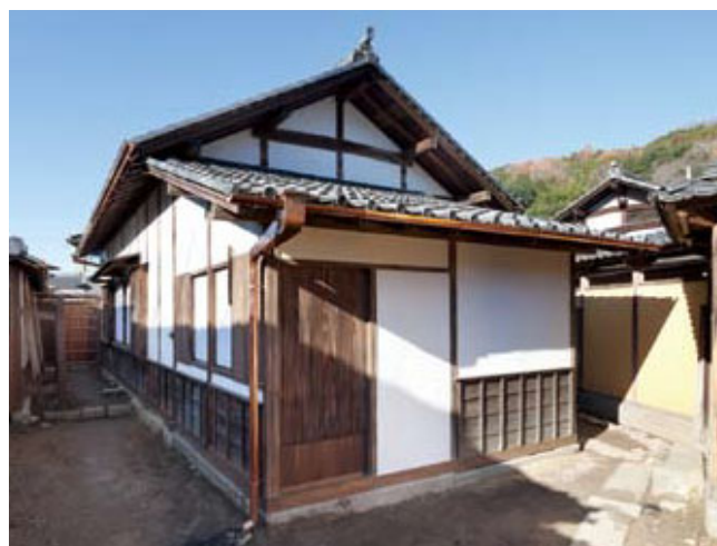
写真 旧鈴木家住宅 旦過寮外観
