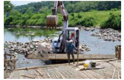
重機でセイタを持ち上げ、ヤナに取り付けます。
